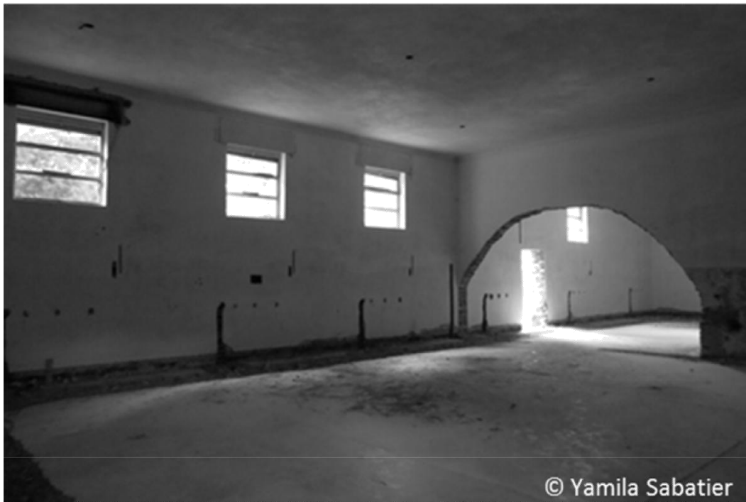
Figura 23. Vista del interior del Laboratorio de química.
