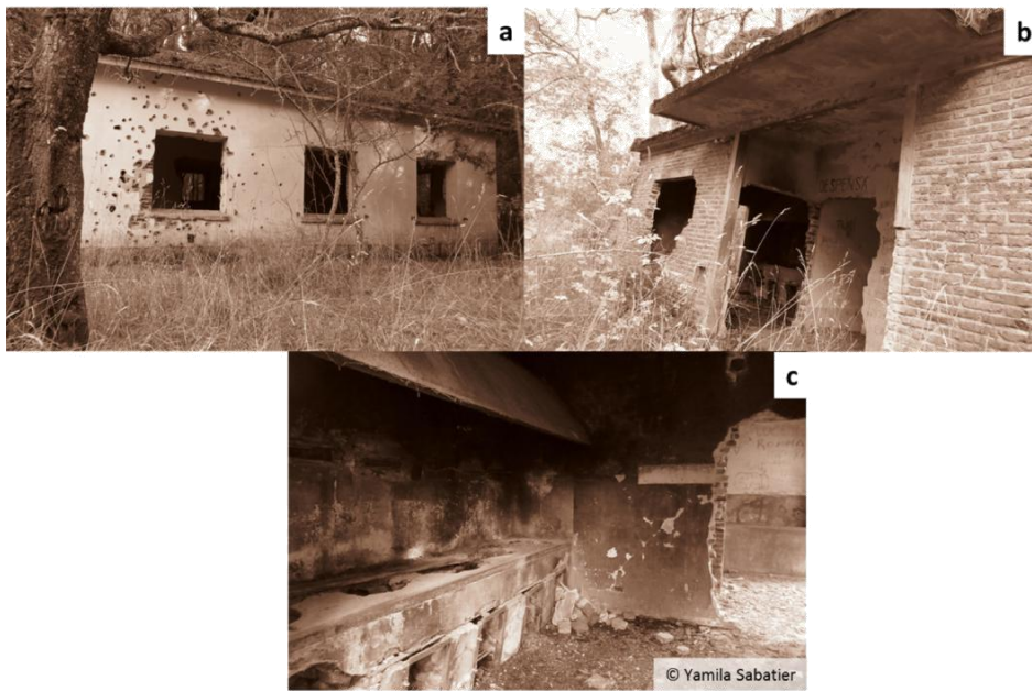
Figura 24. Vistas de la casa de Richter (a) y de la despensa desde el exterior (b) y el exterior (c)
